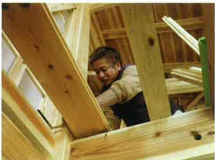
新モデルハウス“環境共棲の家TERRA”にて、杉の床板(40mm)を張る岩木忠彦棟梁。(撮影：中島紀于氏)
